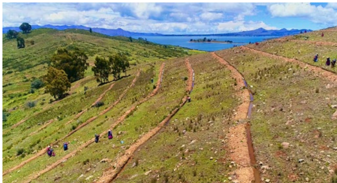
Zanjas de infiltración excavadas en la isla Yuspique, distrito de Anapia, provincia de Yunguyo (Puno).
