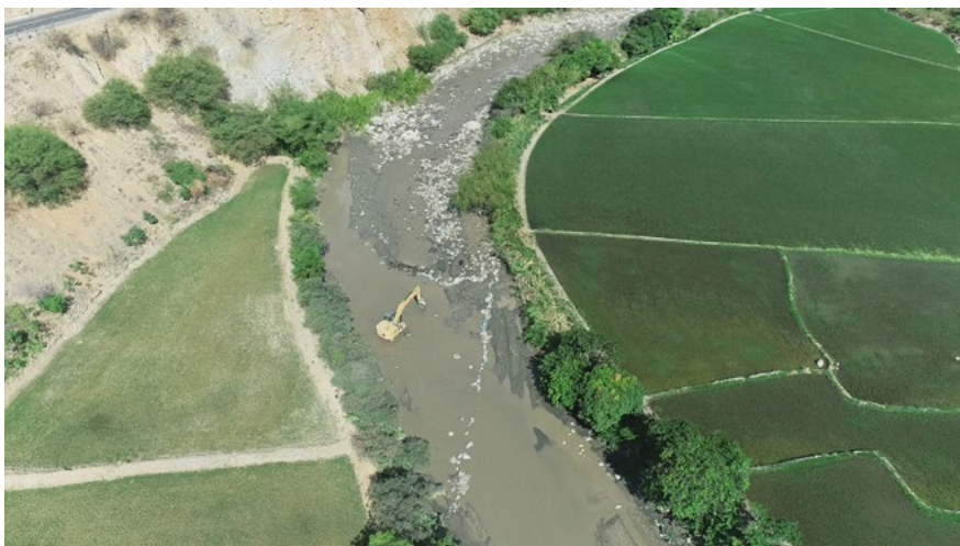
Trabajos de rehabilitación de las tomas de agua.
