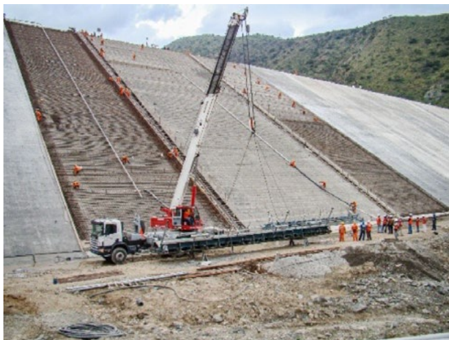
Construcción cara de concreto - Presa Limón (2007)
